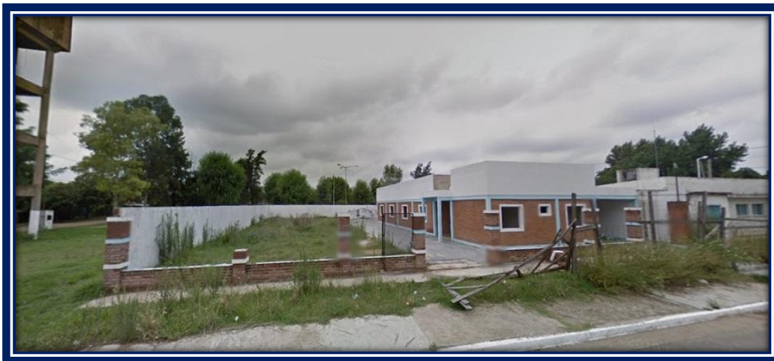
Jardín en construcción entre el tanque de agua y el Centro de Salud
