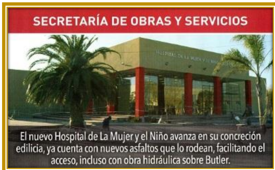
Hospital del Niño y la Mujer en avanzado estado de construcción 1
