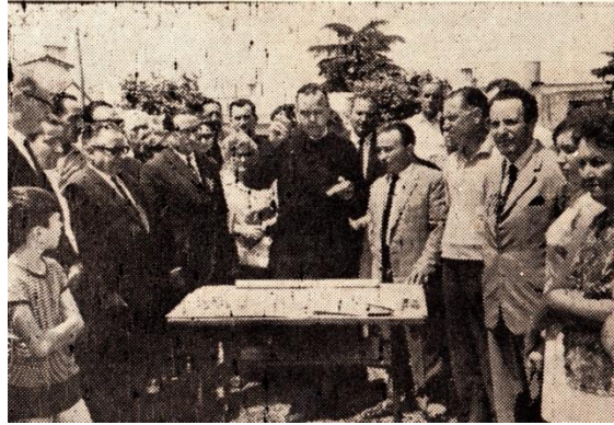
Colocación de la piedra fundamental de la Central Telefónica
