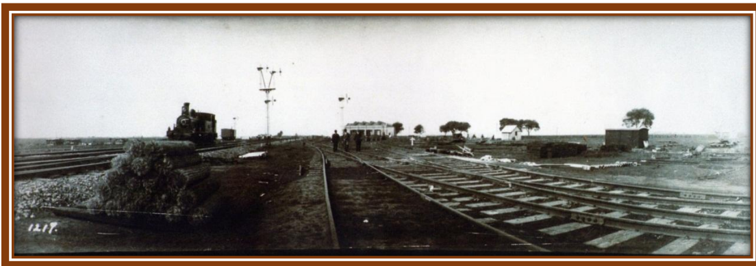
Tendido de Vías, al fondo galpón de máquinas
