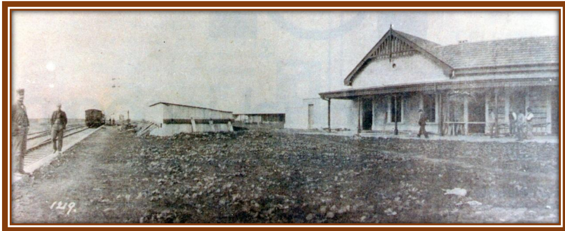
Estación en construcción
