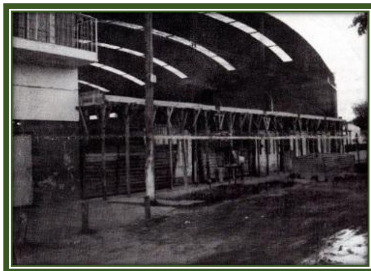
Cerramiento del Gimnasio 7
