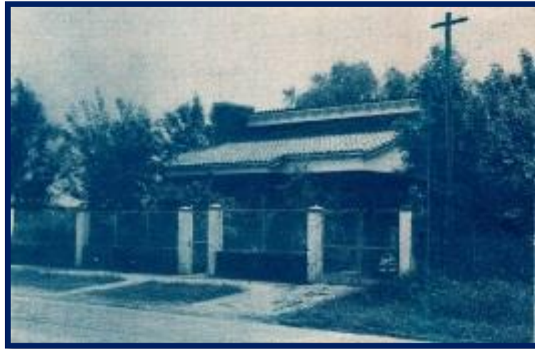
Casa existente en la manzana N° 164 sobre Avenida Gaspar Campos
