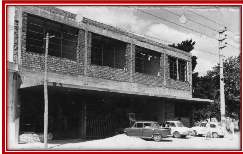
Edificio en construcción para el instituto Giovanni Pascoli
